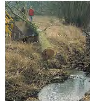
Bild 42 (rechts) Antransport des Gehölzmaterials für die Totholzschwelle (Aspehe)
